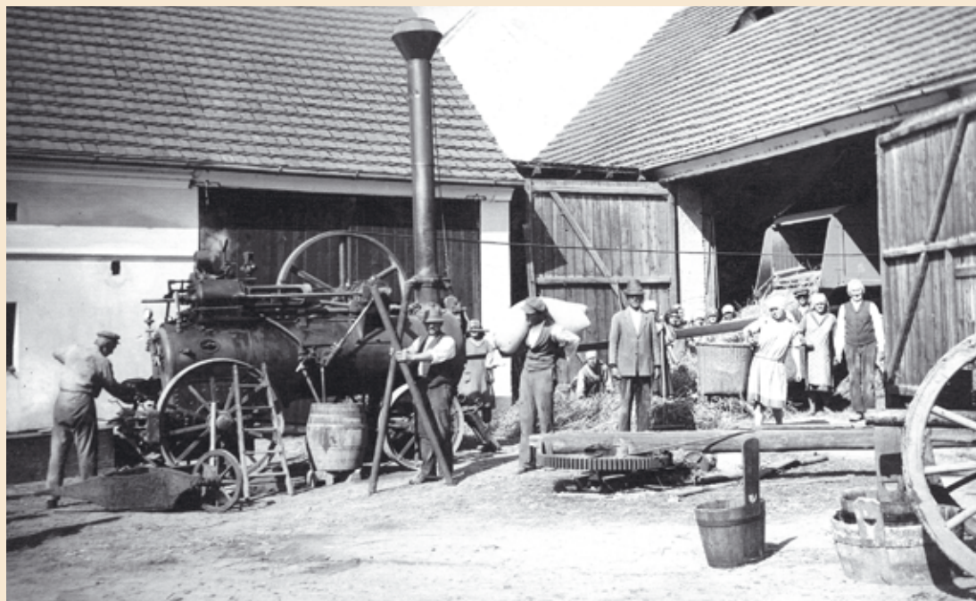
MLÁCENÍ U KÖNIGSMARKŮ. UPROSTŘED SNÍMKU VE SPODNÍ ČÁSTI JE VIDĚT ŽENTOUR, POUŽÍVANÝ K Pohonu stroje ZA VYUŽITÍ KOŇSKÉHO POTAHU. VPRAVO DOLE JSOU PROTIPOŽÁRNÍ NÁDOBY – PUTNA A ŠKOPEK.
