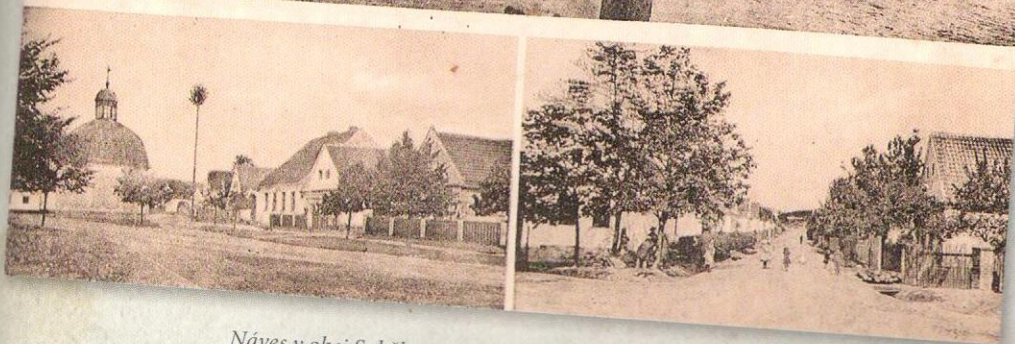
Náves v obci Soběkury, kaple a partie z tehdejší výstavby
